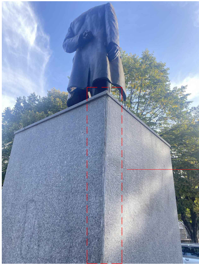
- shpellarje e materialit lidhes midis pllakave - demtim i pllakave ne pjeset anesore te tyre (pllaka jo origjinale)
