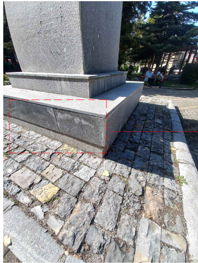
- shpellarje e materialit lidhes midis pllakave - demtim i pllakave ne pjeset anesore te tyre -shkarje te pllakes (pllaka jo origjinale)
